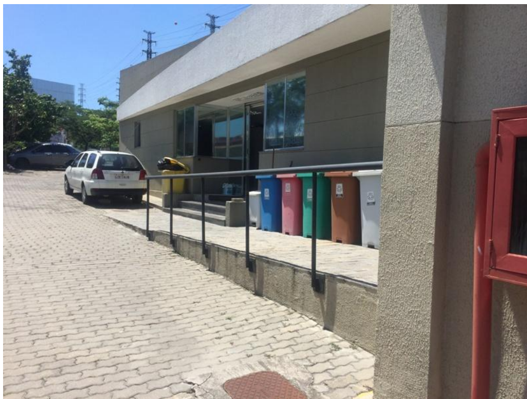
Entrada de serviço, prédio anexo ao principal.
