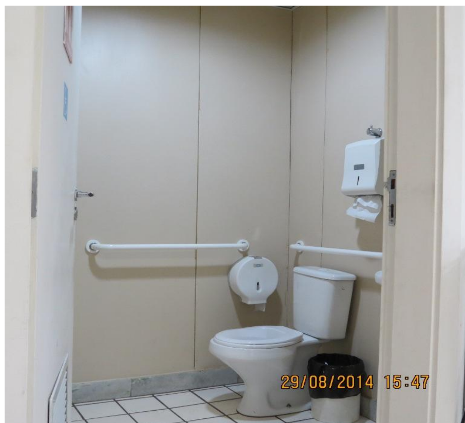
Banheiro dos visitantes (andar térreo).
