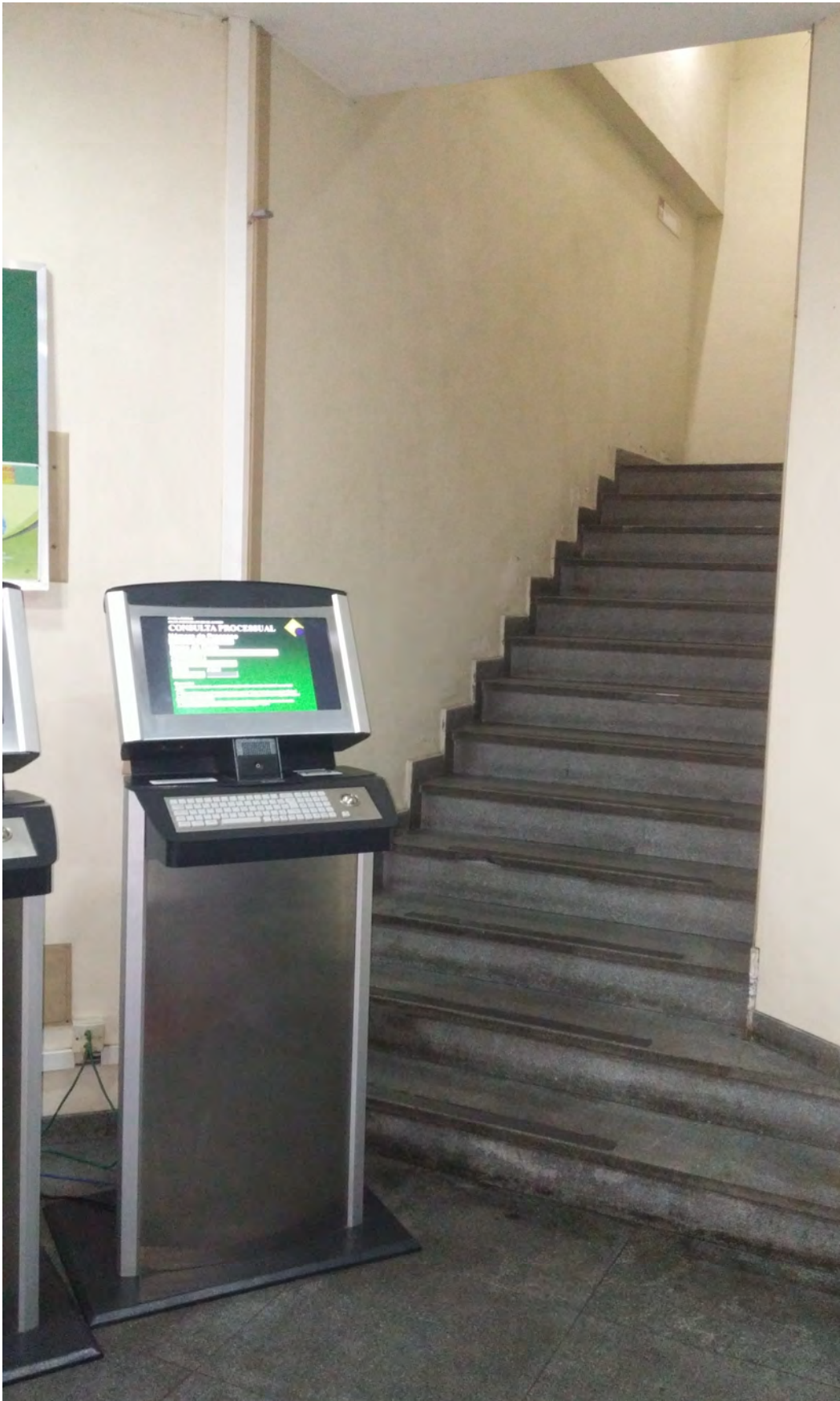
Escada de acesso aos andares superiores
