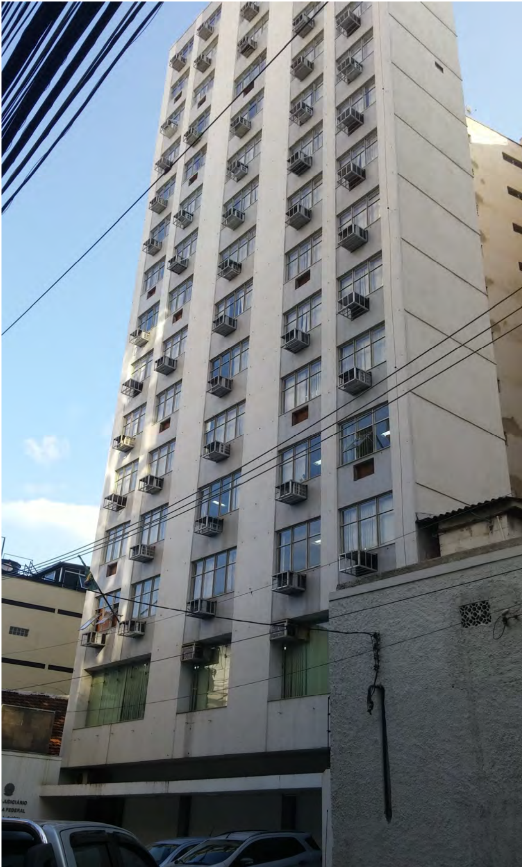
Fachada lateral direita do prédio
