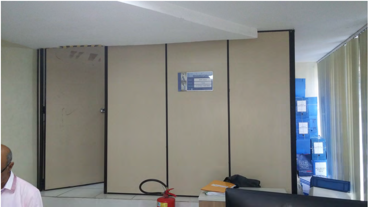
Sala de almoxarifado
