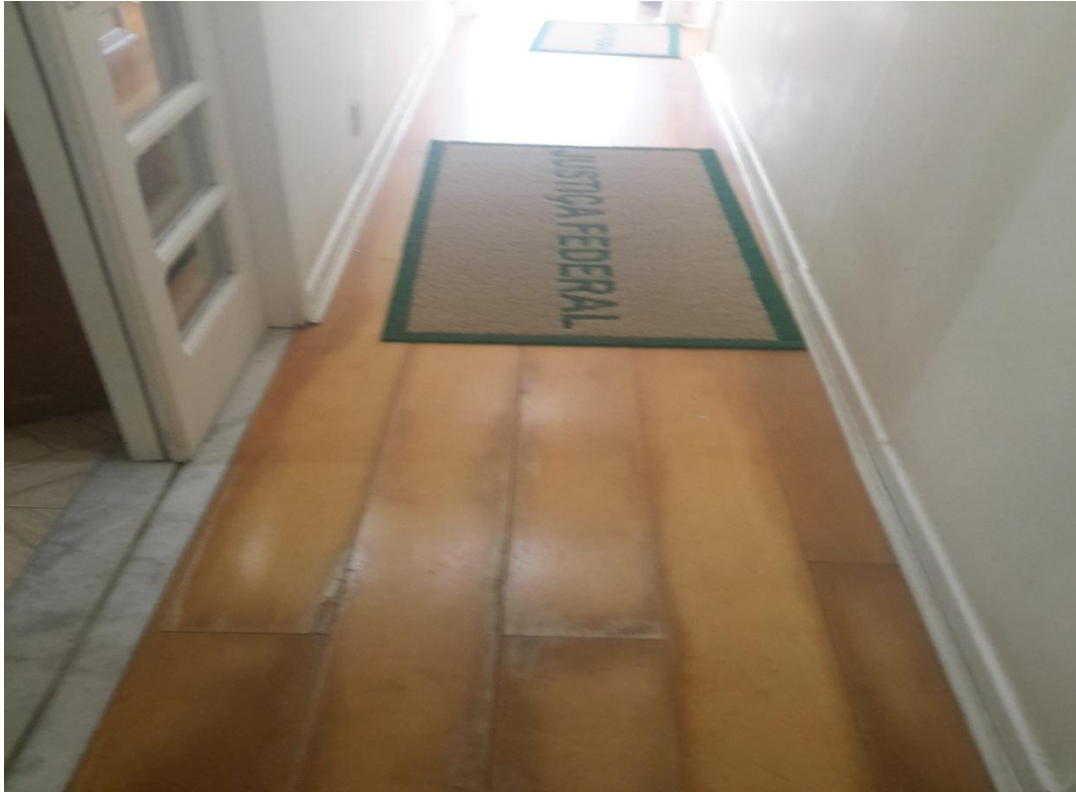
Figura 5 – Piso de madeira, no corredor da Vara, danificado pelas águas das goteiras.
