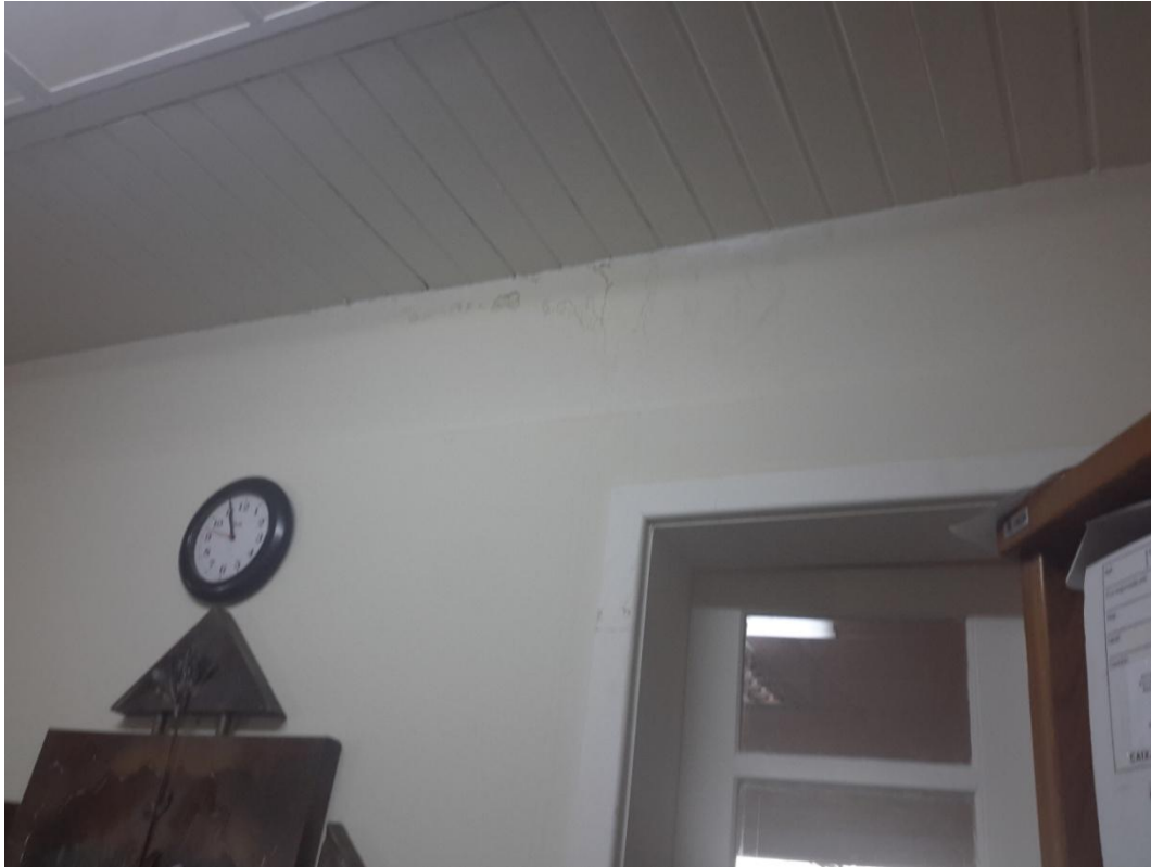
Figura 4 – Infiltrações no teto da 2ª Vara de Petrópolis.
