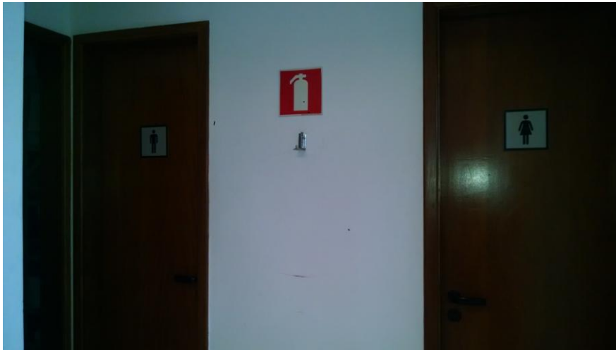
Portas dos banheiros com sinalização. Note-se a ausência de extintor de incêndio
