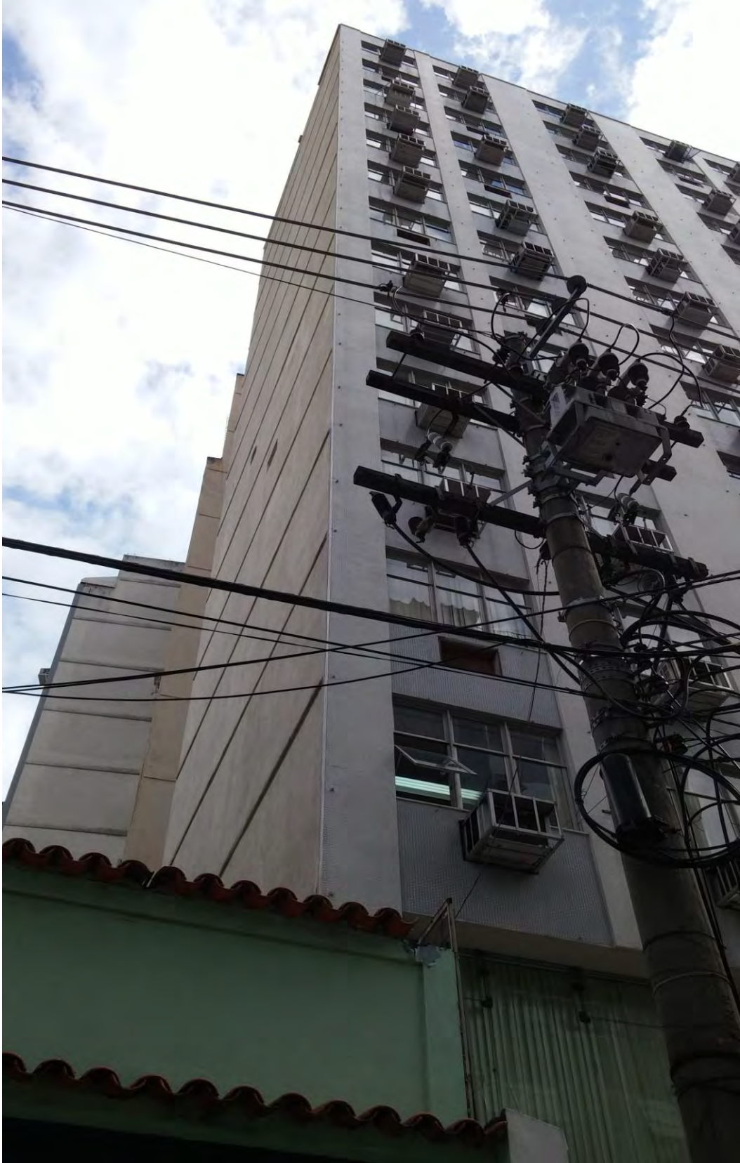
Fachada lateral esquerda
