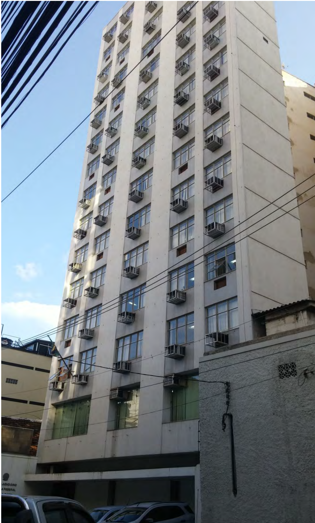
Fachada lateral direita do prédio
