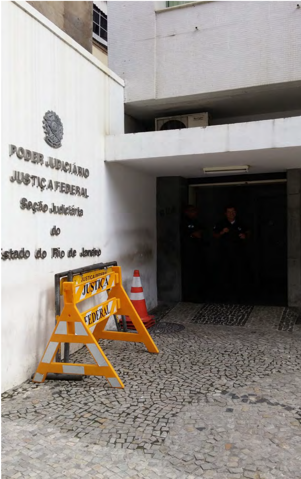
Fachada do prédio
