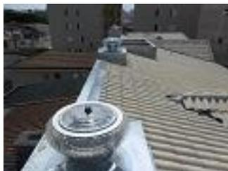
Em razão da inspeção ao telhado da edificação, não se pode deixar de noticiar o péssimo estado das telhas, muitas quebradas e remendadas com isolante para evitar vazamento.
