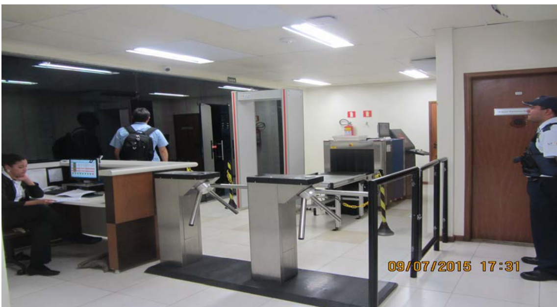
Saída dos fundos: porta com detector de metal e aparelho raio x.
