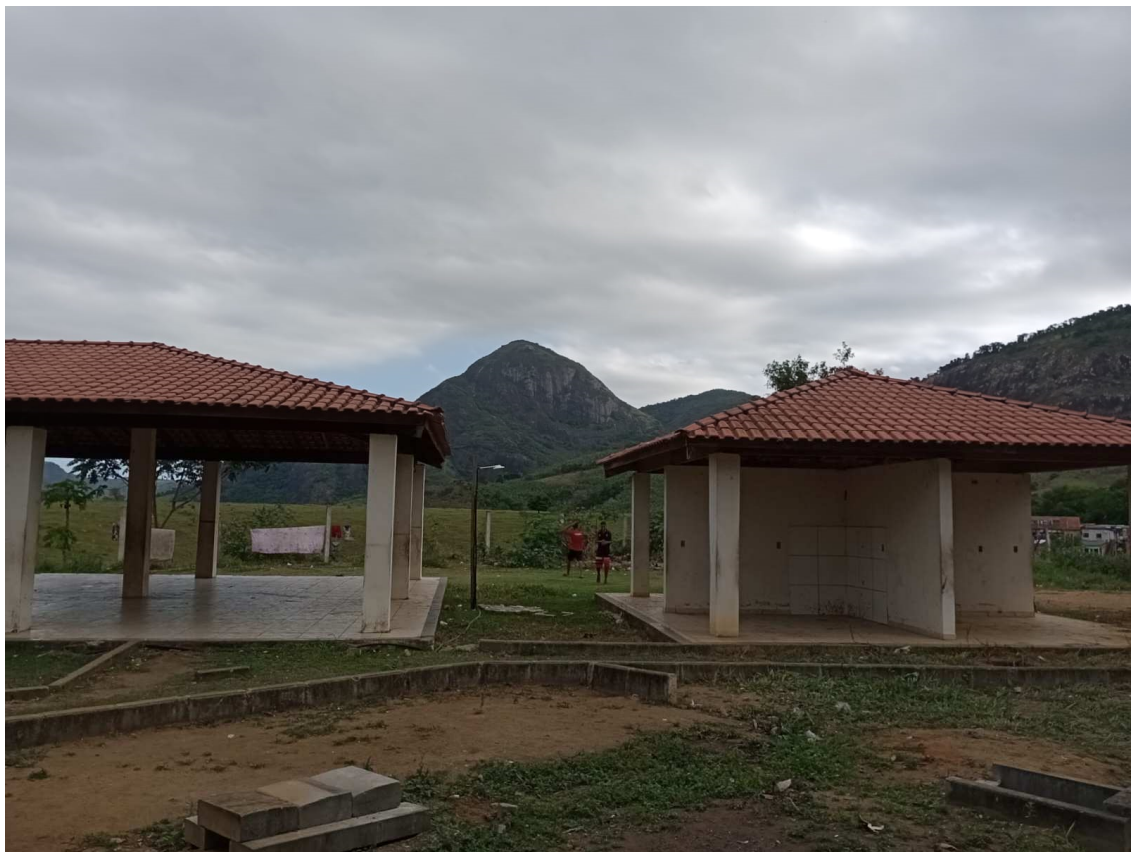
Rede de drenagem utilizada para o esgotamento sanitário e área de lazer do empreendimento.
