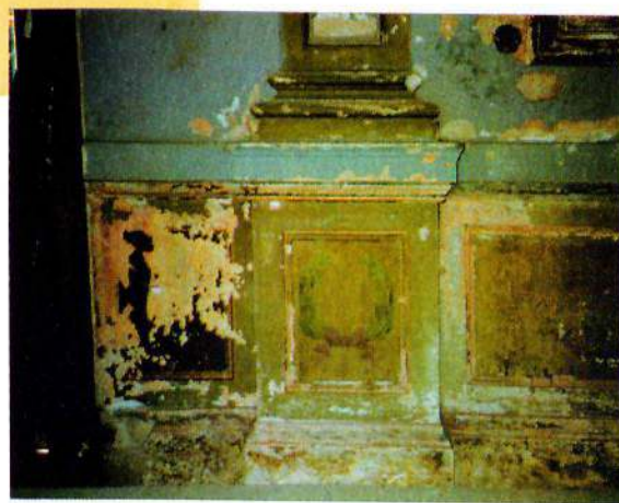
Paredes e colunas antes do processo de restauração
