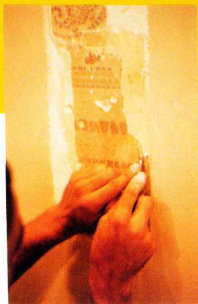
Abertura de janelas de prospecção
