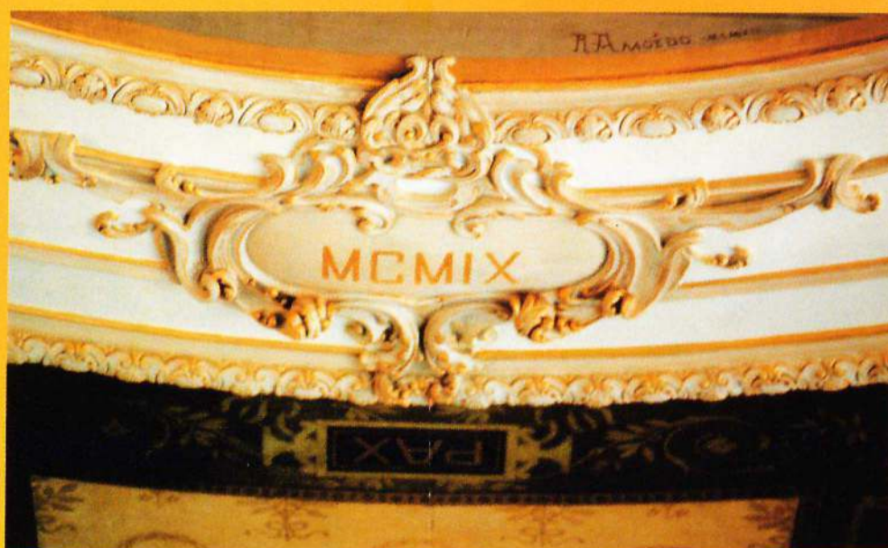
Detalhe do Teto sala de sessões
