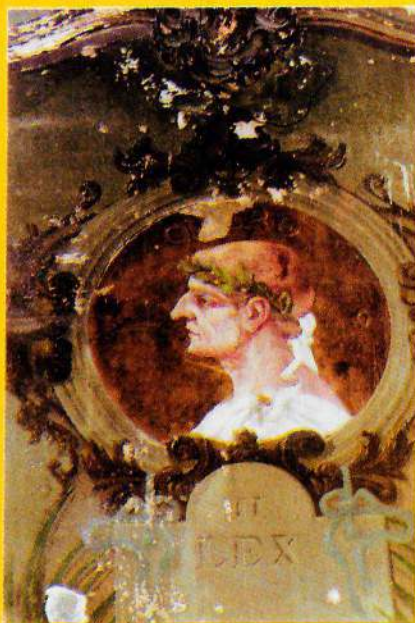
Painéis pintados por Rodolpho Amoêdo danificados com o tempo
